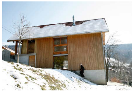
Accès par le haut
